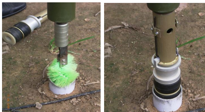
图 4.6 清洁管壁、封堵管底口
