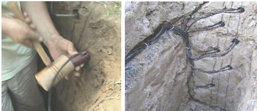
图 4.3 传感器埋设及安装效果图
